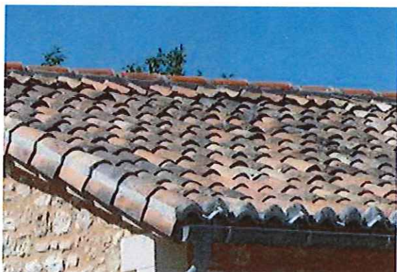
Couverture en tuiles canal neuve
